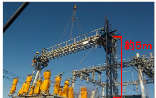
大型工事だとクレーン車も使います
